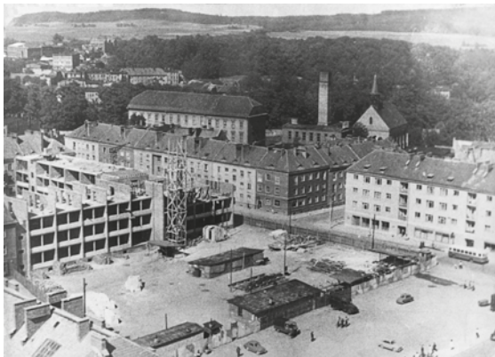
Budowa nowego ratusza, 1960-1962. Fot. T. Fikowicz. Źródło: zbiory Muzeum w Koszalinie
