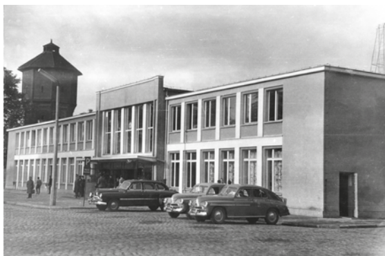
Nowy dworzec kolejowy w Koszalinie, oddany do użytku w 1962 r. Źródło: zbiory Muzeum w Koszalinie
